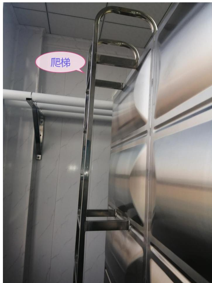
2、外置浮球小水箱应加锁，爬梯设置在人孔和小水箱之间，方便安装维护
