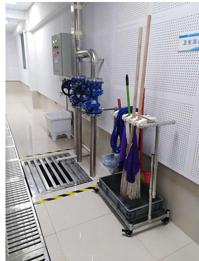
互为备用，自动启动，每台泵不低于 5.5kw，每条出水管口径不低于 DN80cm。
